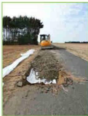
Réalisation d'une purge et mise en place d'un géotextile avant la pose d'un revêtement bicouche.
