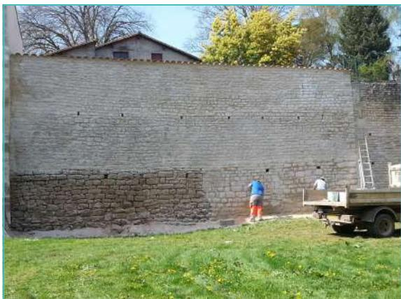
Réfection par nos techniciens maçons de l'enduit du mur de la cour intérieure par piquage et rejointoiement.
